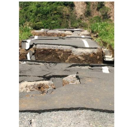
＝阿蘇大橋は崩落し、付近道路は亀裂や段差が生じていました。土砂崩れにより民家は押し流され、地震の規模を物語っています。
